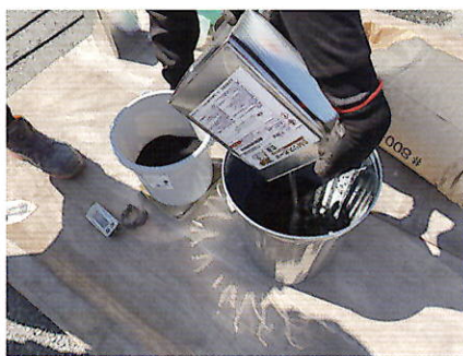
A液とB液、ゴムチップを混合。
